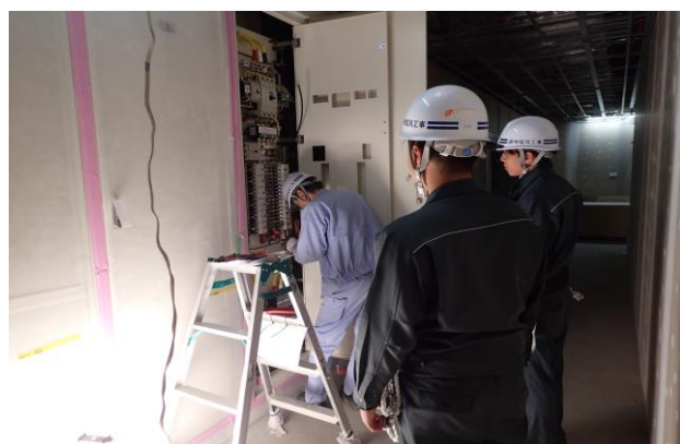
分電盤結線作業の説明
