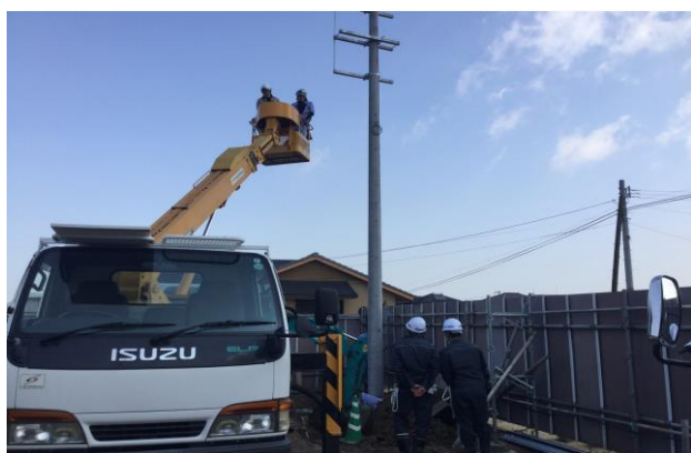
装柱材取付作業の見学
