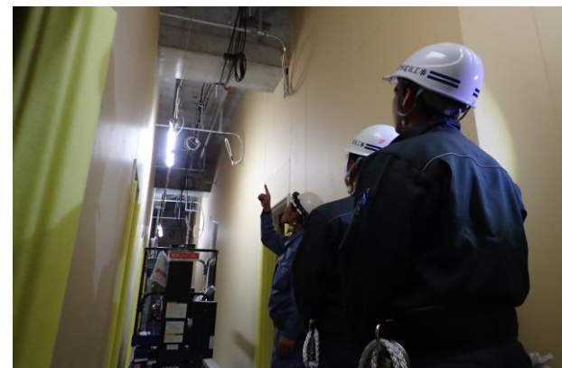
天井配線状況の説明
