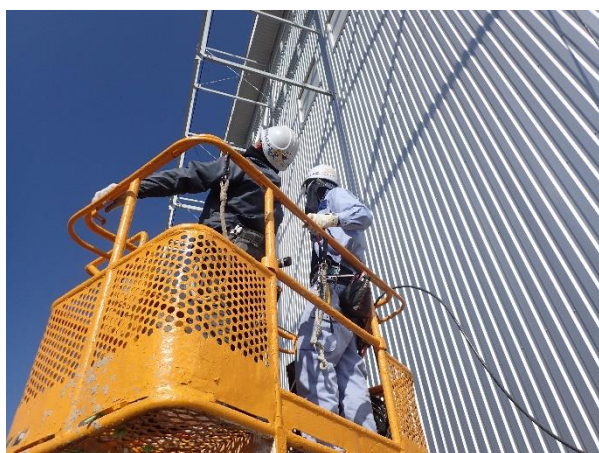
高所作業車で器具付けに向かいます
